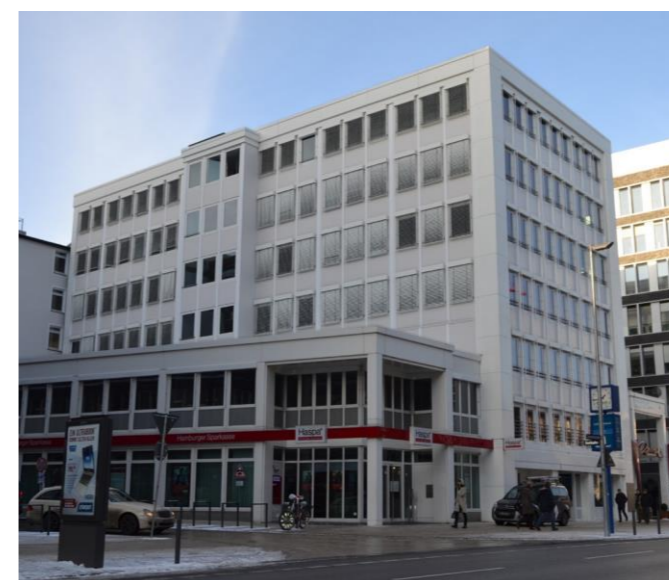
Dienstgebäude des Sozialgerichts Hamburg in der Dammtorstraße in Hamburg
